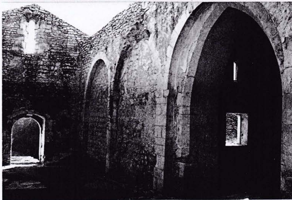
Vue intérieure du mur nord-ouest, ouverture de la chapelle gothique
