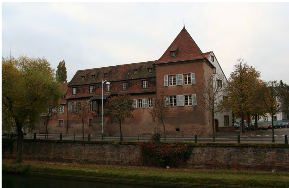
Tour de dépôt d'artillerie (1200-1250) englobée dans l'Arsenal municipal (XVI e siècle) puis dans la Fonderie Royale de canons (1703) - 18, Quai Schoepflin, Strasbourg
